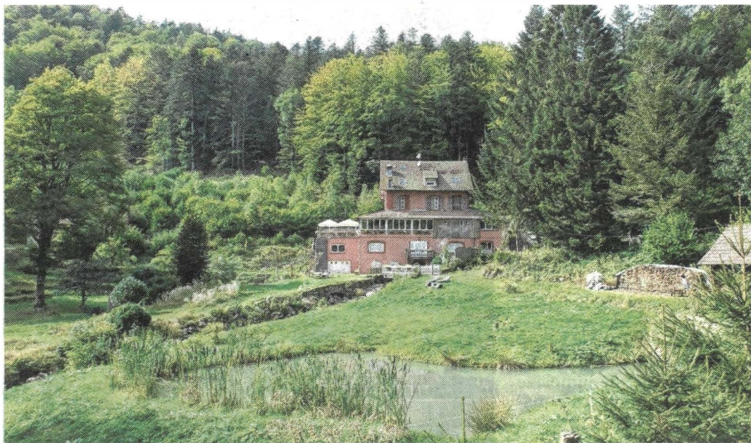
La guinguette sera installée à l'arrière de l'ancien hôtel-restaurant, sur cet espace.
